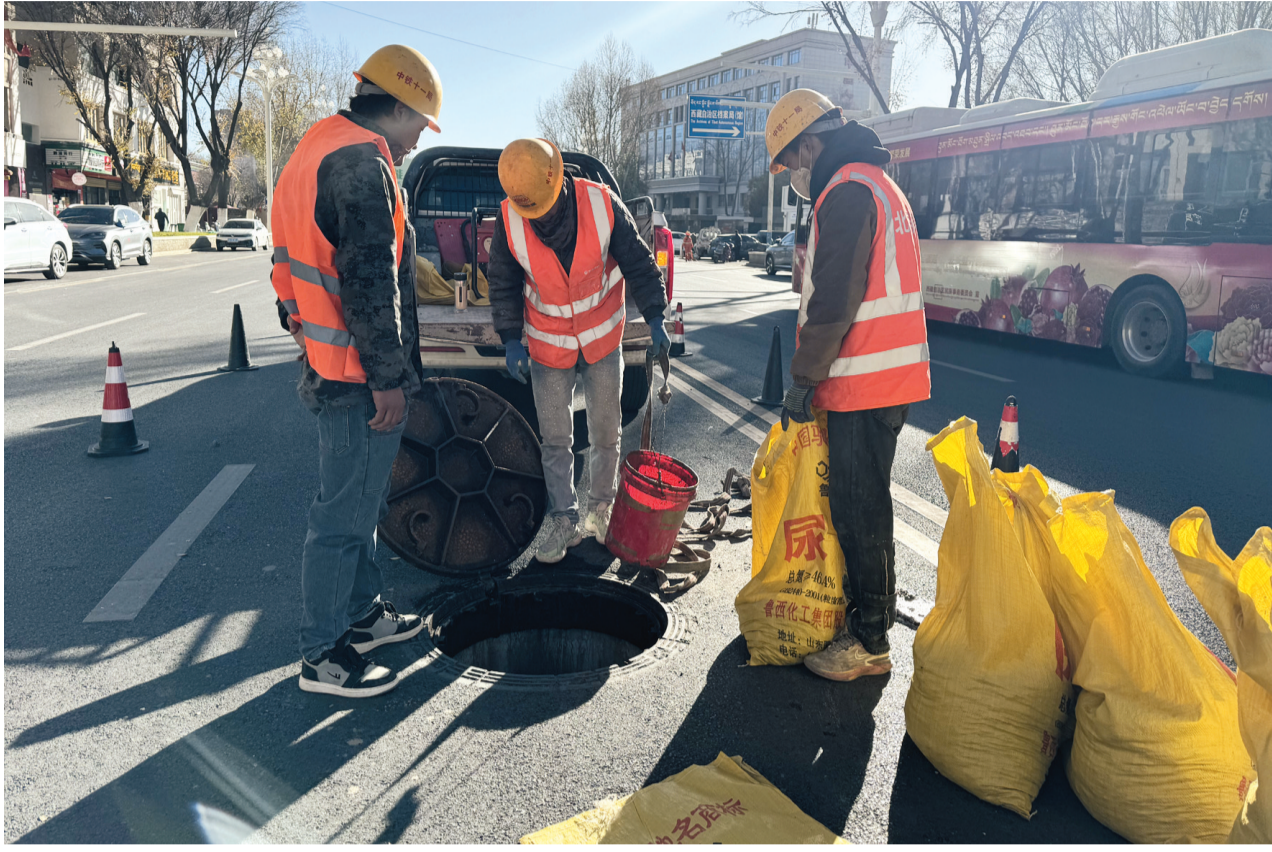
图为施工方正在对部分道路进行收尾作业。
