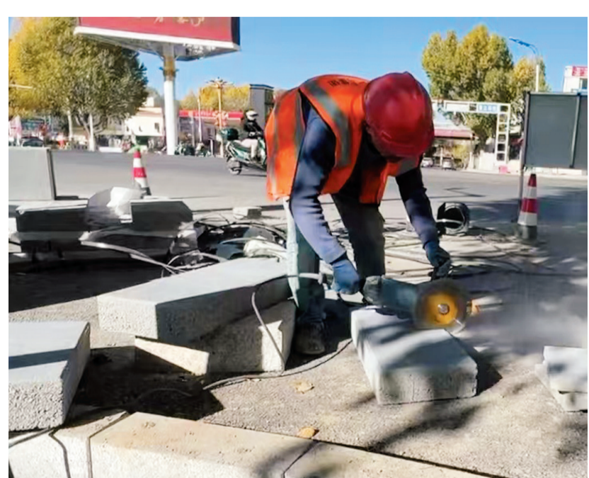
图为工作人员正在进行透水砖切割工作。
