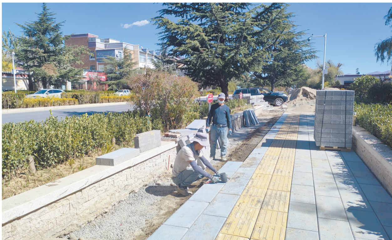
图为工作人员在罗布林卡路上铺设透水砖。
