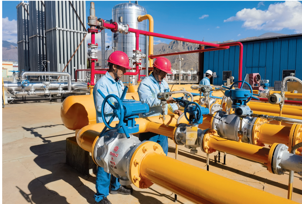
图为工作人员正在该站工艺区进行燃气检漏工作。
