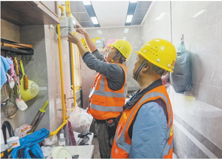
图为四川省佳成建设有限公司工作人员在小区为住户安装燃气报警器和自闭阀。
