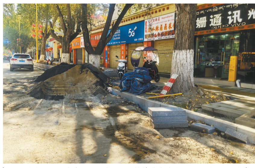
图为施工区域未设立围挡，施工材料随意堆放，施工垃圾不及时清理。拉萨融媒记者 次仁卓玛摄
