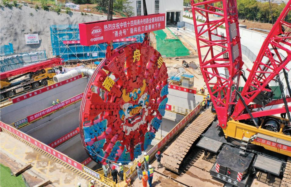
甬舟铁路金塘海底隧道西起宁波市北仑区，东至舟山市金塘镇，全长16.18公里，其中盾构段长11.21公里。甬舟铁路西起宁波东站，东至定海区白泉镇，设有7个车站，线路全长约77公里，设计时速250公里。项目建成后对于完善铁路网布局，推动宁波舟山一体化、同城化发展等具有重要意义。
