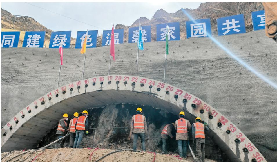
图为拉萨北环西延线项目二标段堆龙三号隧道项目工程进洞开挖现场。
