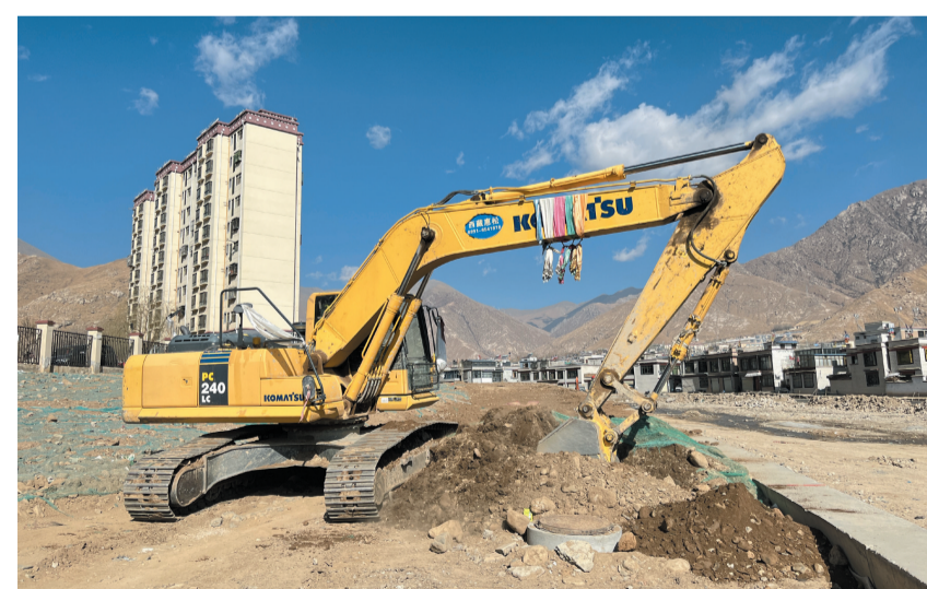
图为挖掘机正在进行整理路基作业。
