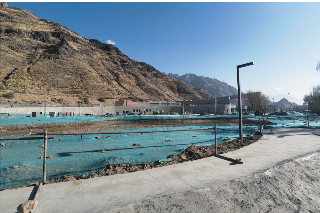
图为堆龙德庆区民族团结主题公园项目建设现场。
