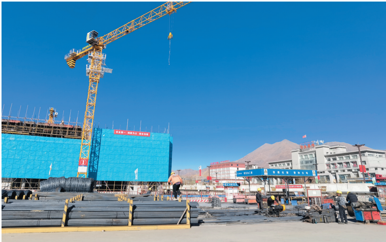
图为达孜绿色新动能产业园一期建设现场。
