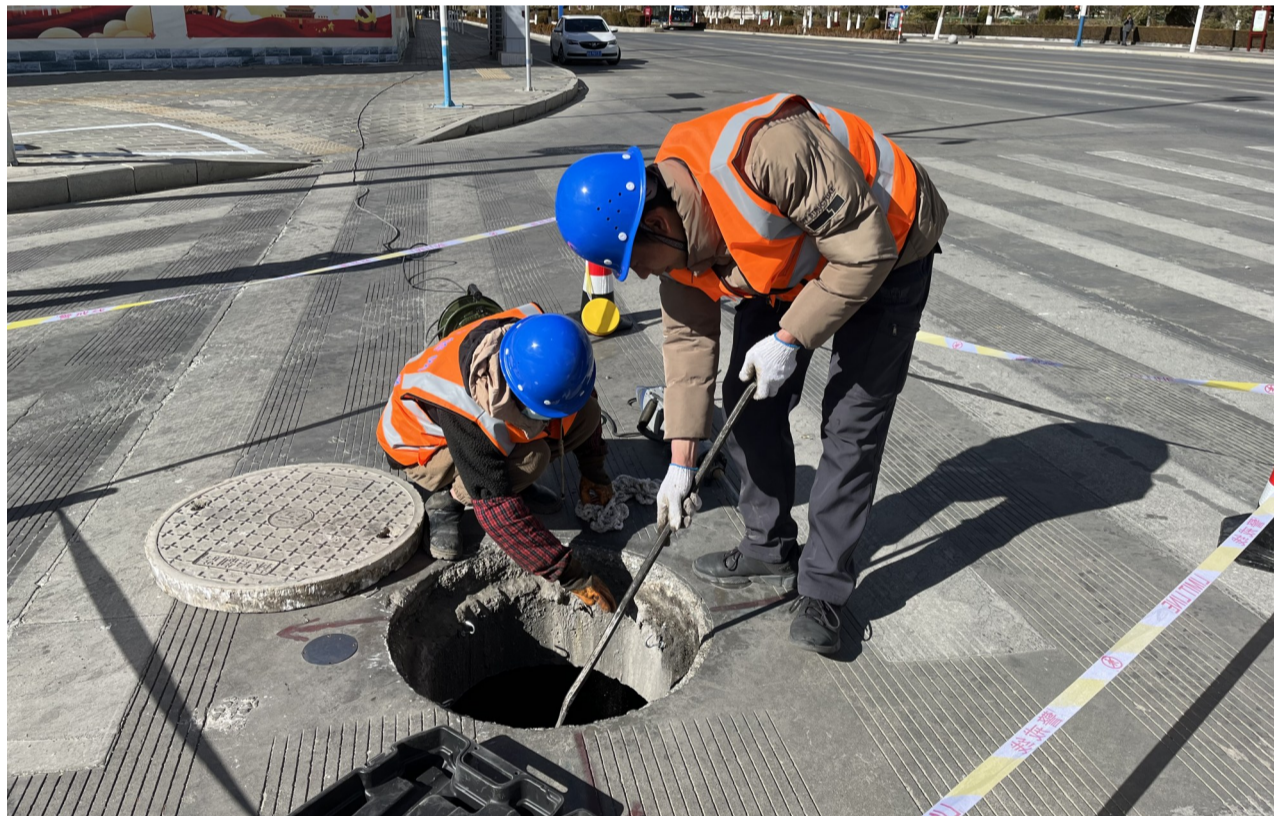
图为工人在对检查井进行维修。
