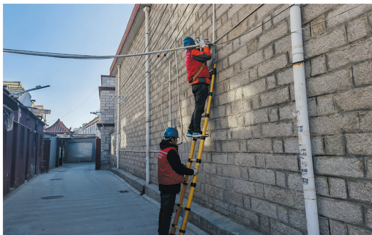
图为国网拉萨供电公司工作人员对城关区八一社区各类线缆进行整治。 拉萨融媒记者 杨璐摄
