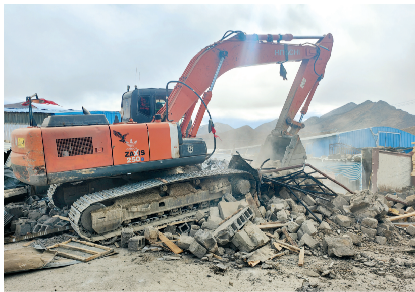
图为违法建筑拆除现场。 拉萨融媒记者 拉姆次仁摄
