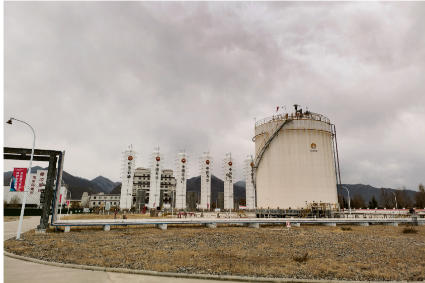
图为昆仑能源西藏有限公司拉萨天然气站内LNG储气罐。 拉萨融媒记者 李从芳摄
