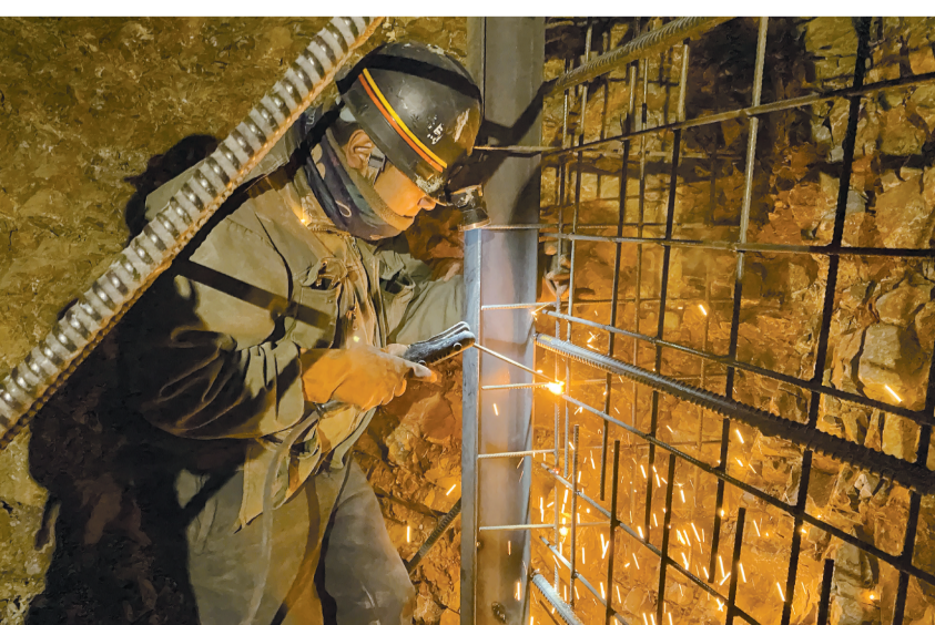
图为施工人员正在作业。拉萨融媒记者 拉杰摄
